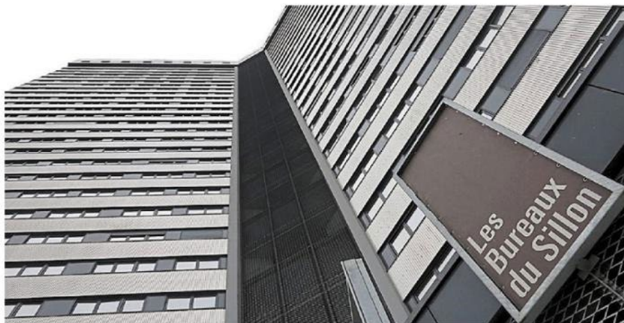
Dans les vingt-huit étages de la tour centrale du Sillon de Bretagne, plus de 130 entreprises prennent de la hauteur !
